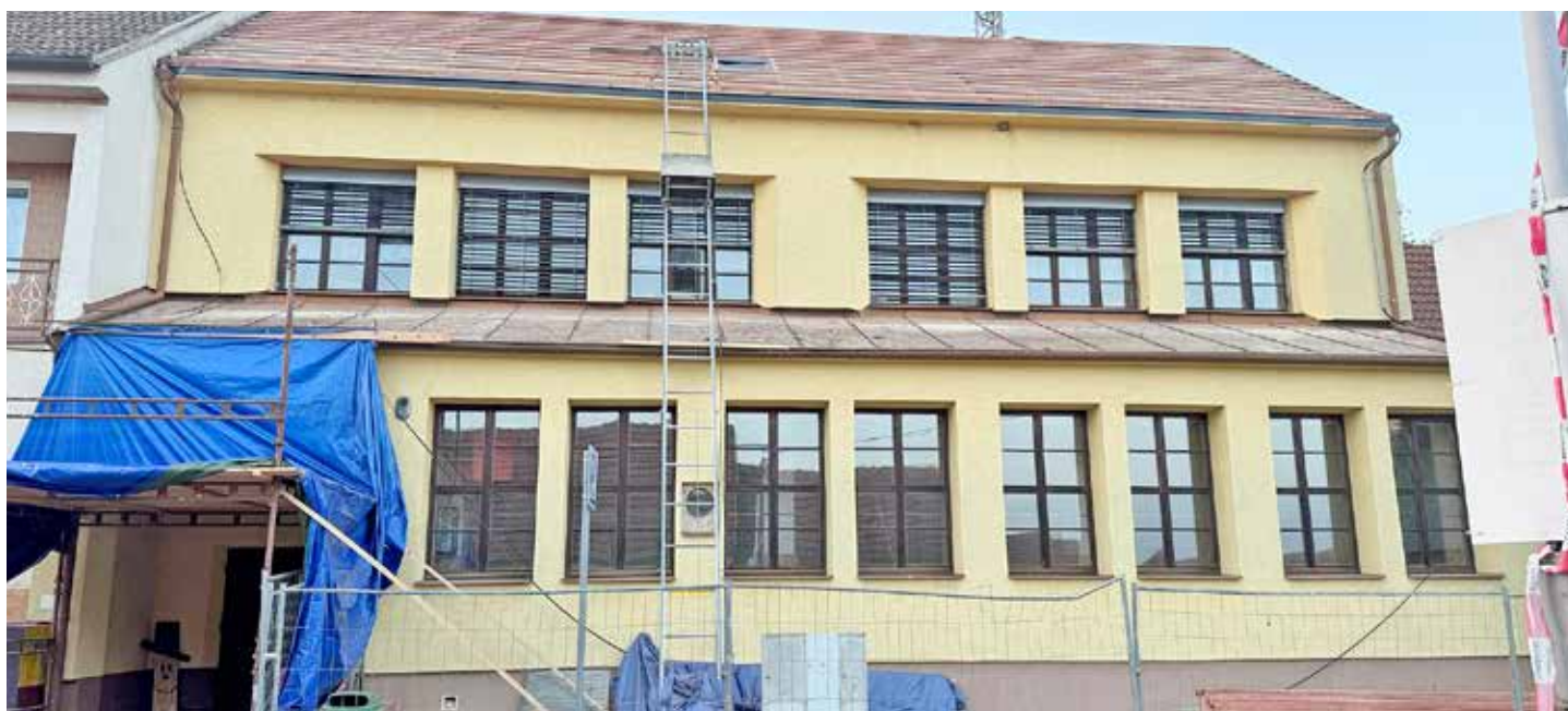
Na podzim se opravovala střecha na základní škole, foto J. Michna
