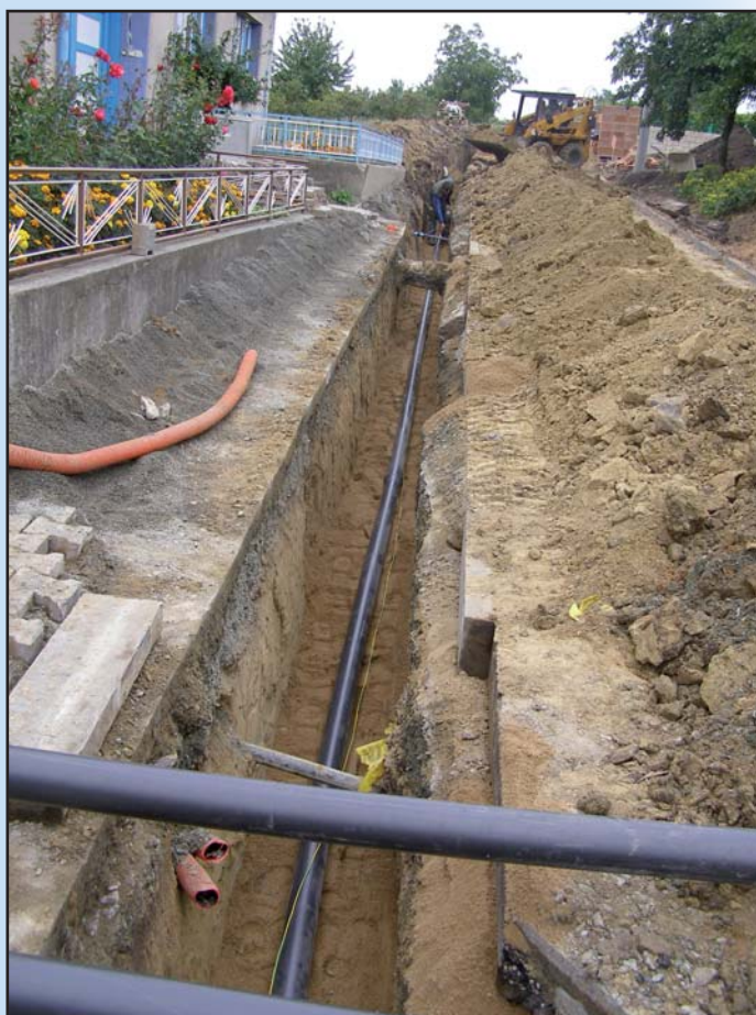
Prodloužení vodovodu na Tálkách
