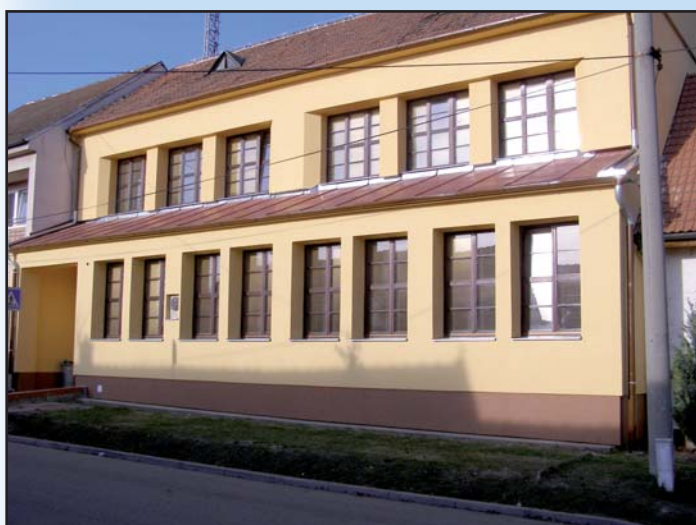
Nová budova ZŠ po rekonstrukci, zateplení
