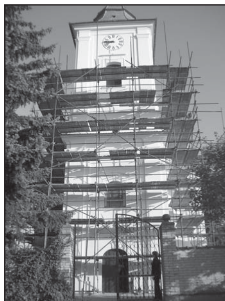
Oprava kostela před dokončením
