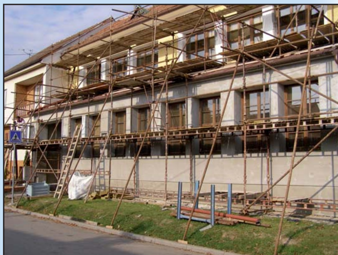
Zateplení nové ZŠ
