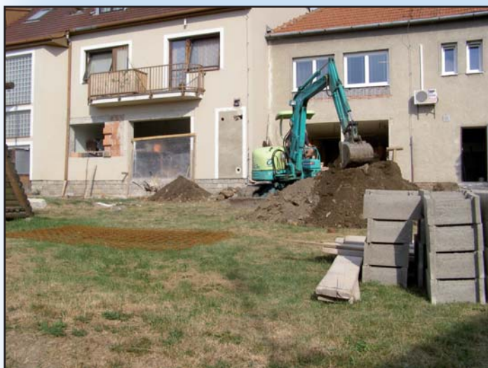
Začátek stavebních prací na přístavbě MŠ
