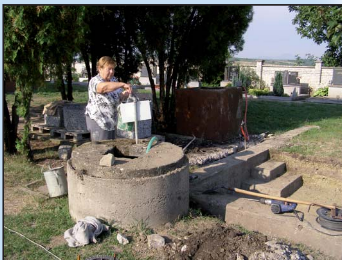
Úprava před usazením kašny na hřbitově
