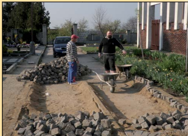
Výstavba chodníků na hřbitově
