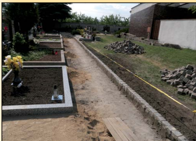
Výstavba chodníků na hřbitově
