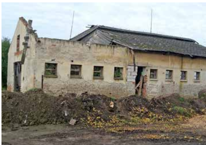
Žleby – stav před demolicí
