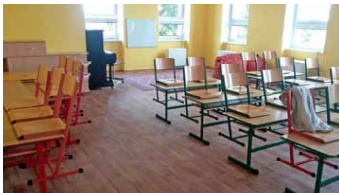
Výměna podlahy ve škole
