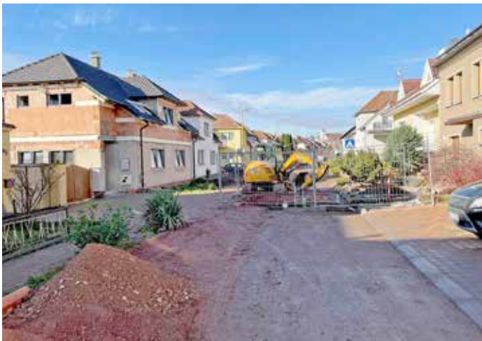
Byla zahájena výstavba kanalizace, foto J. Michna
