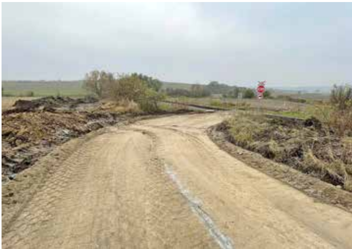
Byla zahájena výstavba kanalizace, foto J. Michna
