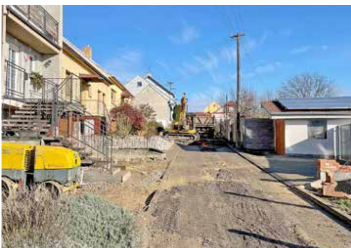
Byla zahájena výstavba kanalizace, foto J. Michna
