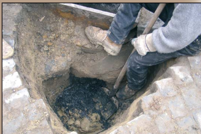
Oprava nedbale provedené opravy kanálu
