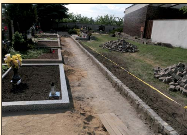
Výstavba chodníků na hřbitově
