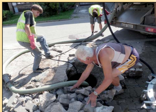
Čištění kanalizace za Humny
