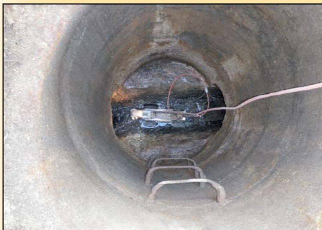
Kamerová kontrola vyčištěné kanalizace za Humny
