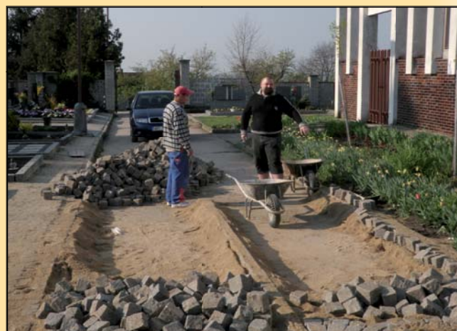
Výstavba chodníků na hřbitově
