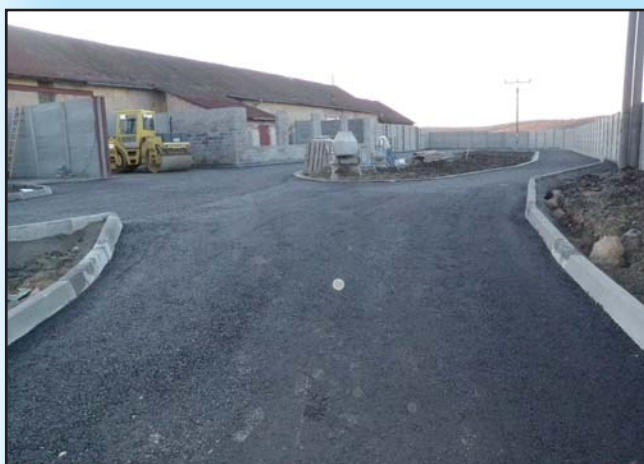
Výstavba sběrného dvoru
