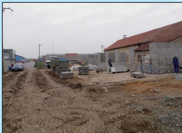
Výstavba sběrného dvoru
