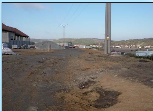
Výstavba sběrného dvoru
