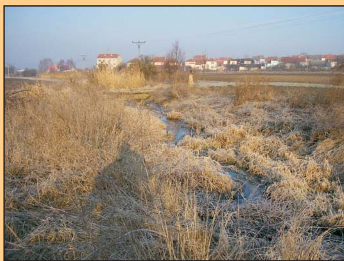
Zanesený járek před čištěním
