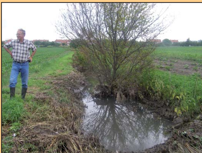
Neodtékající kanalizační stoka pod Bukovským
