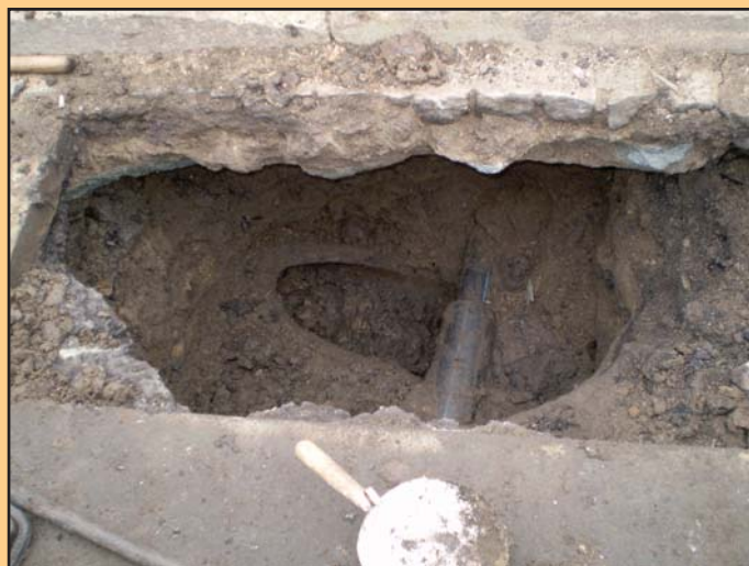
Oprava kanálu u Chrástkového
