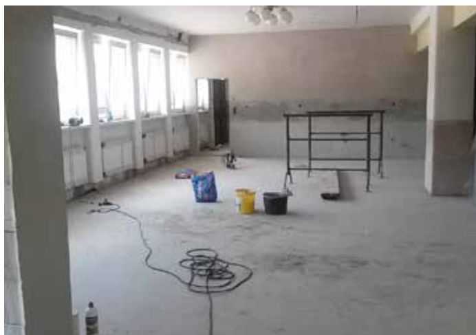
Oprava baru v KD
