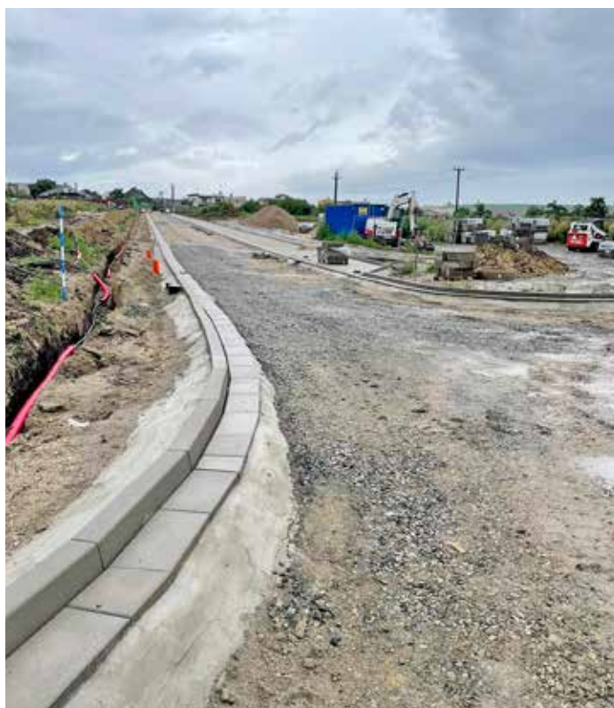
Nová ulice Záhumenice-Příhon ve výstavbě, foto J. Michna
