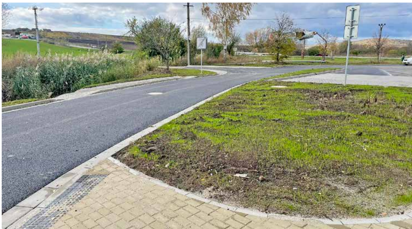
Opravený prostor před hasičskou zbrojnicí, foto J. Michna
