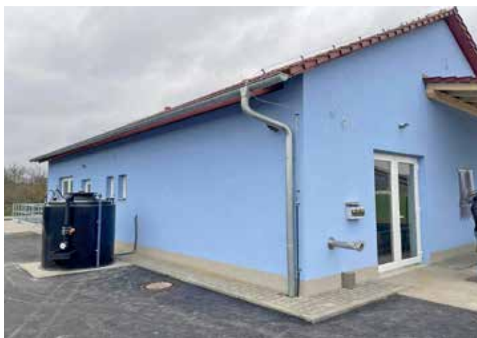
Budova ČOV je hotová, foto J. Michna
