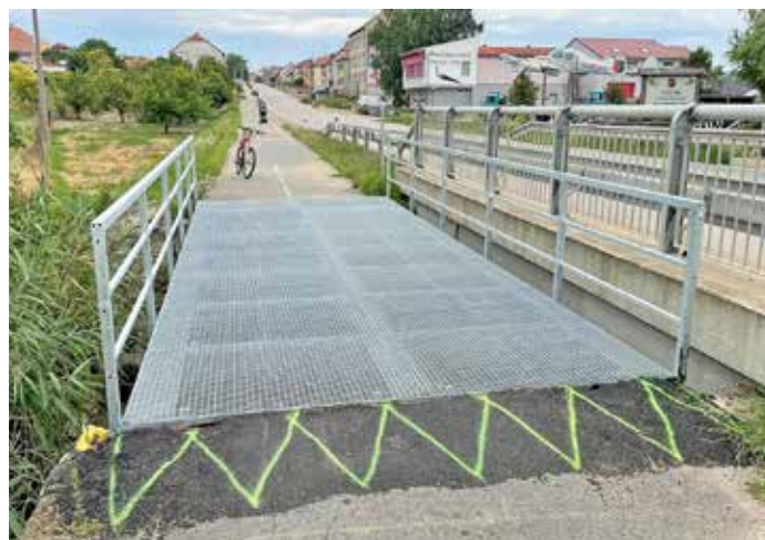
Opravený mostek na cyklostezce, foto J. Michna
