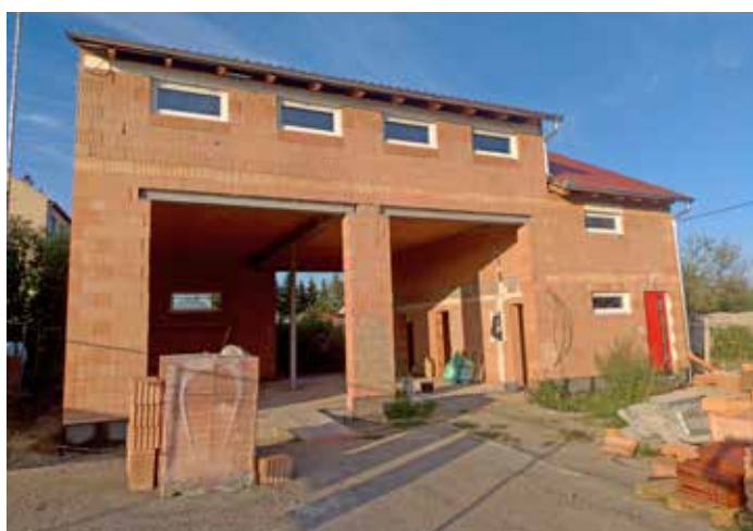
Stavba hasičské zbrojnice
