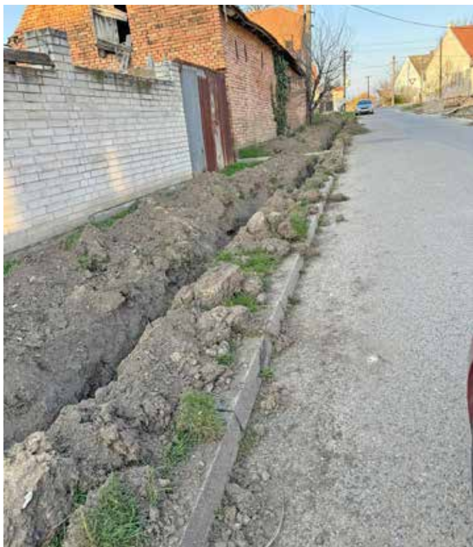
Budování optické sítě v obci započalo, foto J. Michna
