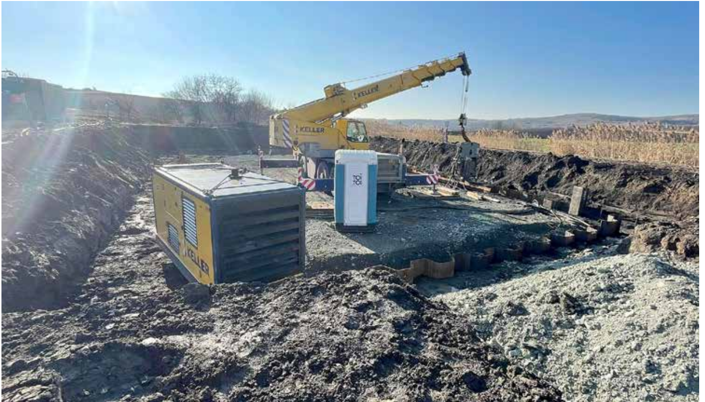
Práce na výstavbě ČOV pokročily, foto J. Michna
