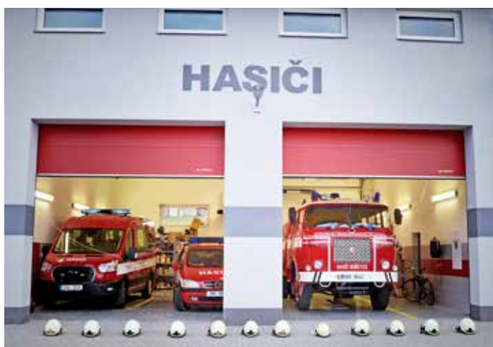
Nová hasičská zbrojnice, foto L. Krejčí
