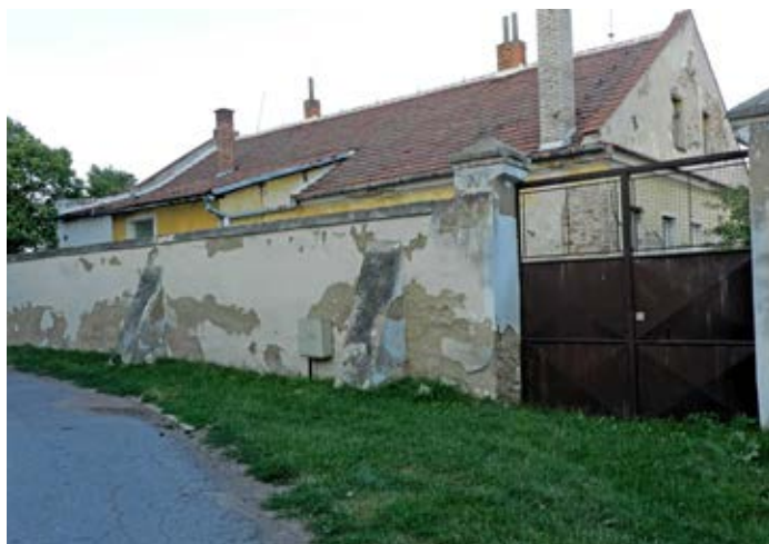
Fara z boku před opravami
