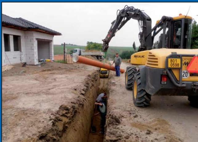
Budování inženýrských sítí v nové ulici Pod bytovkami
