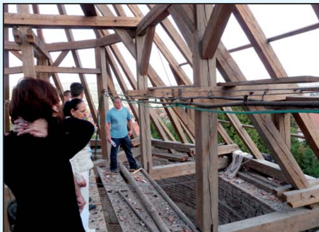
Oprava střechy kostela
