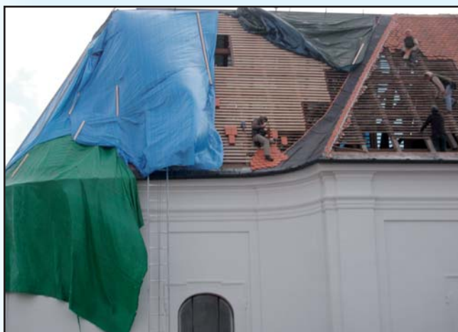
Oprava střechy kostela
