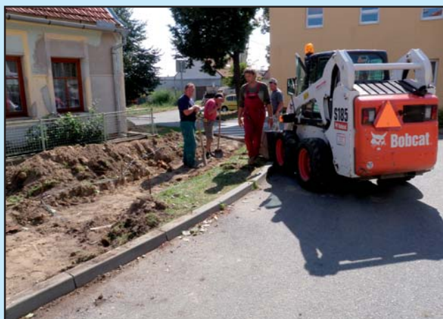
Budování chodníků před školou
