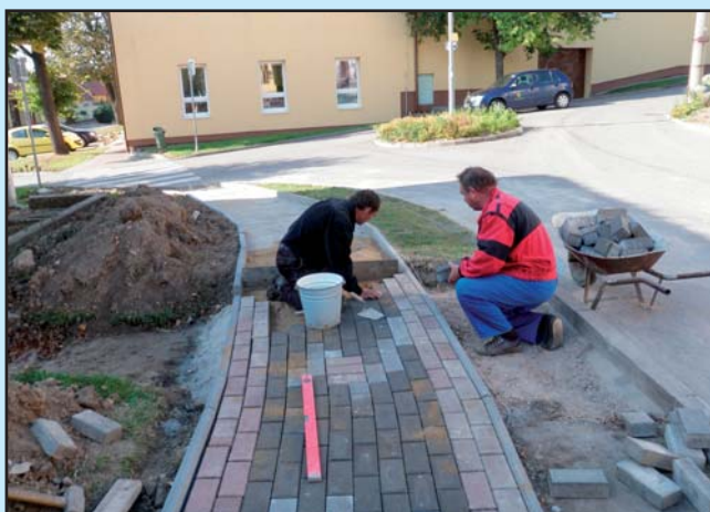
Budování chodníků před školou
