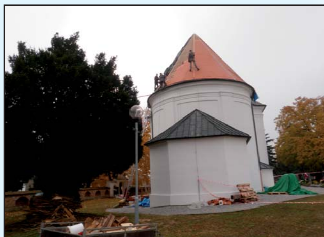
Oprava střechy kostela
