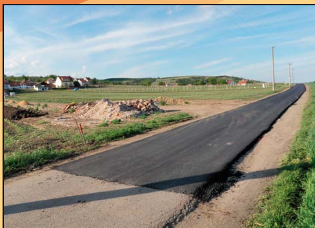
Nový asfaltový povrch na cestě do Hliníků
