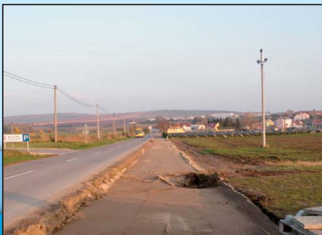
Budování nové cyklostezky
