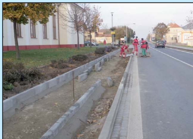
Výstavba chodníku kolem kulturního domu
