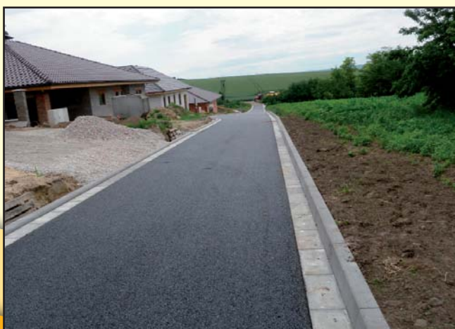
Nová vozovka v ulici Pod bytovkami
