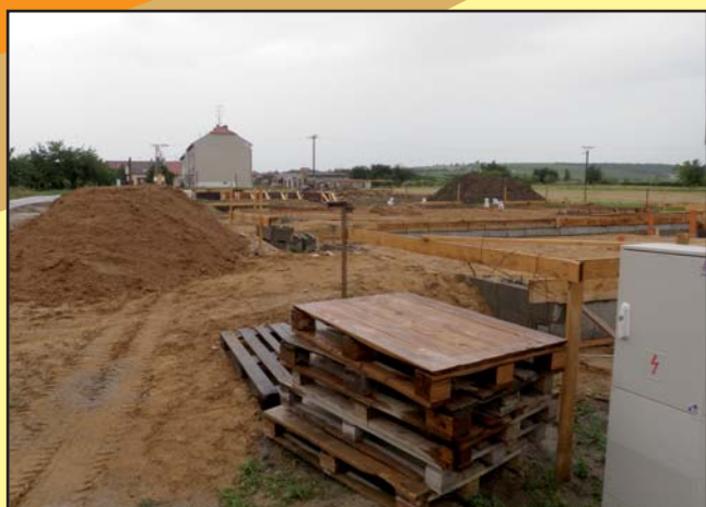
Výstavba nové ulice pod bytovkami
