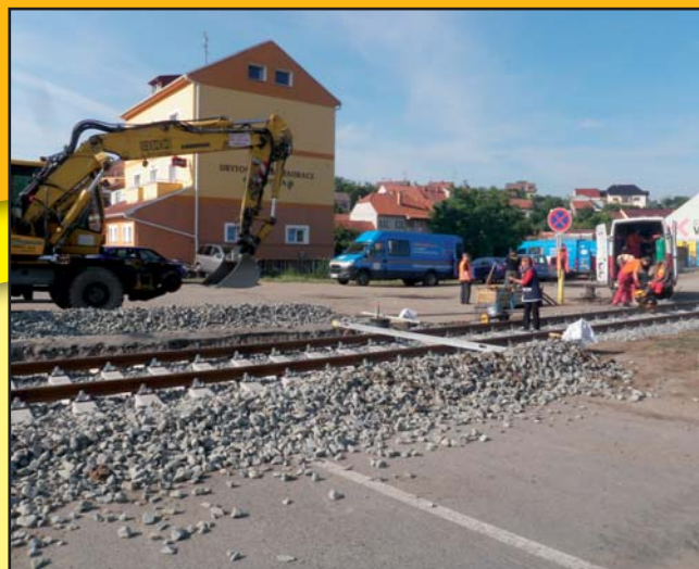
Oprava železničního přejezdu
